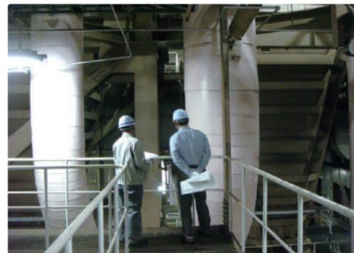
高温再熱蒸気管は、高温高圧(約600℃、約5MPa)の蒸気に曝されており、クリープ損傷が蓄積されています。機器の安全な運用のためにも、クリープ余寿命を的確に把握することが重要です。
