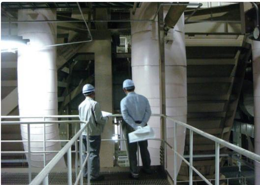
高温再熱蒸気管は、高温高圧(約600°C、約5MPa)の蒸気に曝されており、クリープ損傷が蓄積されています。機器の安全な運用のためにも、クリープ余寿命を的確に把握することが重要です。
